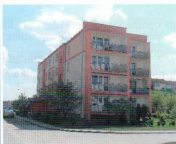
Budynek przy ul. Leśnej 9A
