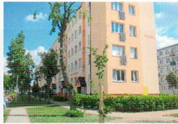
Budynek przy ul. Norwida 3
