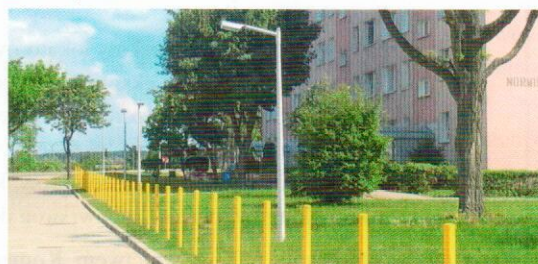
Oświetlenie zewnętrzne terenu między budynkami Norwida 7 i Norwida 9
