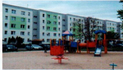
Budynek przy ul. Biedrawiny 6
