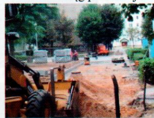
Ciąg pieszo – jezdny w traktacji remontu
