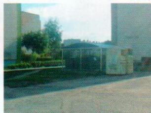
Altanka śmietnikowa w szczycie budynków Leśnej 9 i 11A
