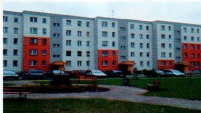
Budynek przy ul. Biedrawiny 4
