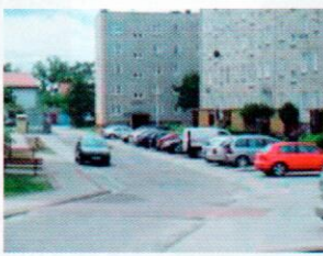
Parking pomiędzy budynkami Norwida 23, a Norwida 25 OBECNIE
