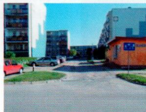
Droga wewnętrzna wzdłuż budynku Malewskiej 1 (przed)
