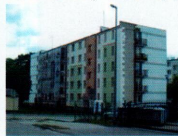
Budynek przy ul. Nidzickiej 11
