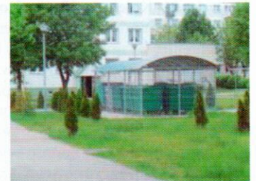
Altanka śmietnikowa przed budynkiem przy ul. Nidzicka 13
