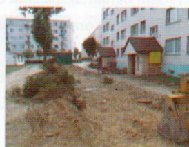
Ciąg pieszego - jezdni przy ul. Lenartowicza 3 (przed)
