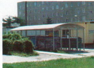
Altanka śmietnikowa przy ul. Norwida 21
